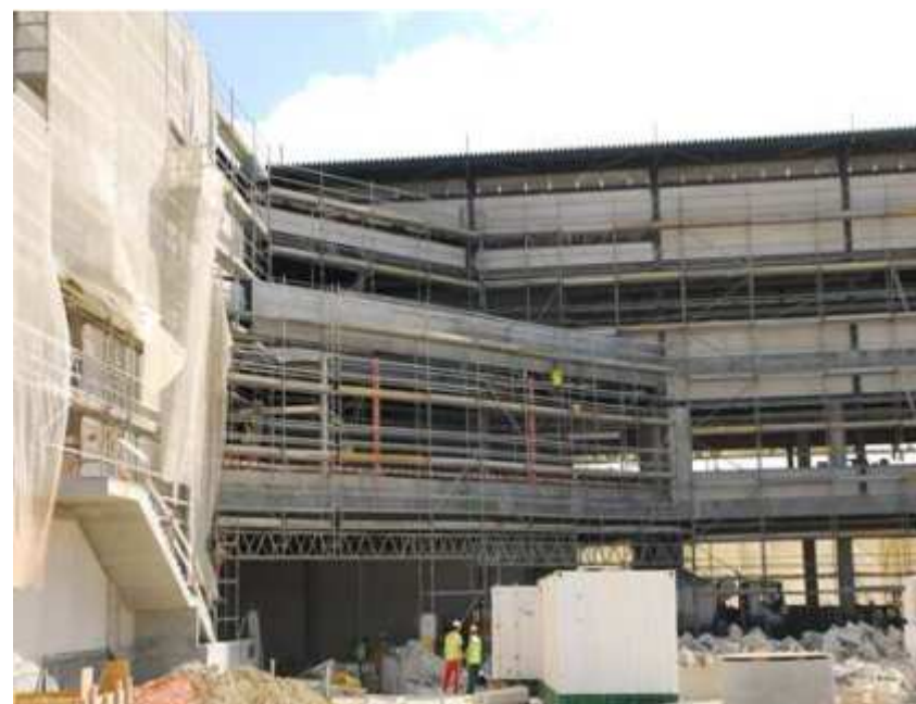
Construção do cais norte do aeroporto de Lisboa
