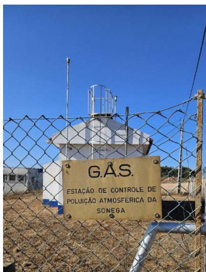
Figura 2 – Estação de Controle de Poluição Atmosférica da Sonega
