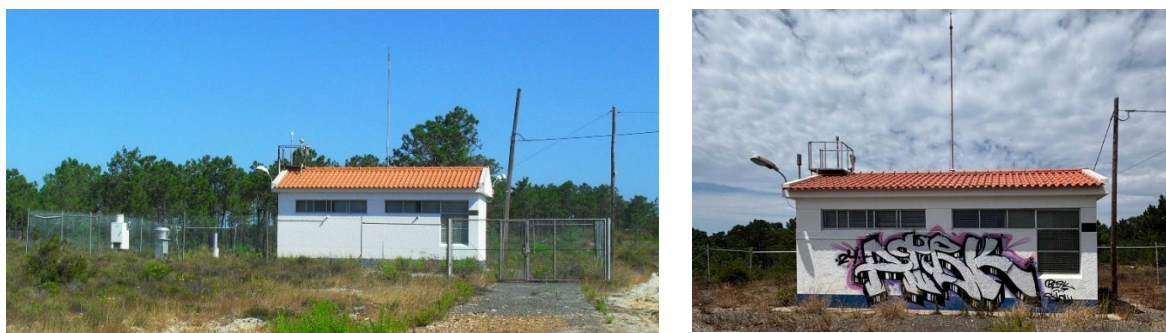
Figura 7 – Estação de Monitorização de Monte Velho
